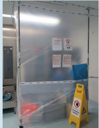
Abbildung 13 b: Arbeitsplatzabtrennung, (Quelle: Firma Henkel Beiz- und Elektropoliertechnik)
