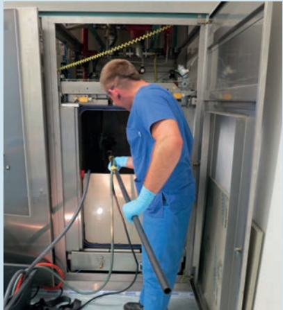
Abbildung 13 a: Vorortsanierung einer Kammerinnenoberfläche durch elektrochemische (anodische) Reinigung (Quelle: Firma Henkel Beiz- und Elektropoliertechnik)
