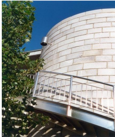
Edelstahl-Außengeländer elektrochemisch poliert, Werkstoff 1.4435
