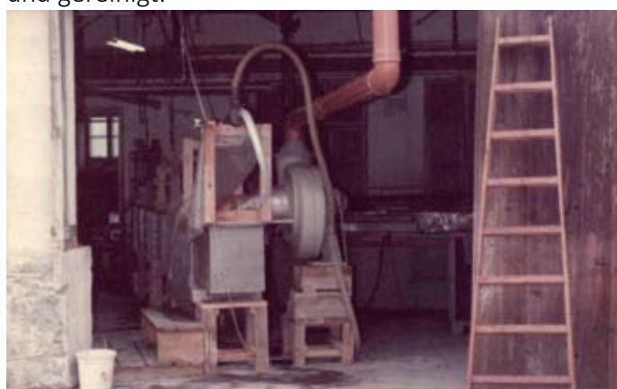
Elektropolieranlage für Rohre 1983
