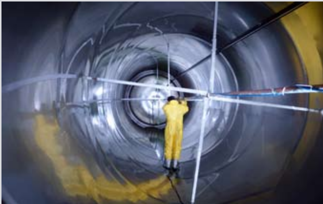
Innenseitiges Elektropolieren eines 150 Kubikmeter Tanks im Werk Waidhofen/Thaya mit flexibler Wischkathode.
