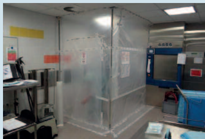
Creating a work area (dust protection wall) (source: Henkel Beiz- und Elektropoliertechnik)
