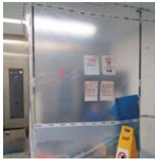
Einhausung zum Schutz des laufenden Betriebes
