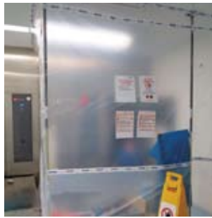
Einhausung zum Schutz des laufenden Betriebes
